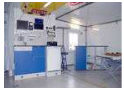
Abb. Beispiel UHS/BHP im Container
